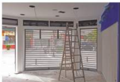
τοποθέτηση ρολών ασφαλείας ηλεκτρικά με μοτέρ κλειστού τύπου ή διάτρητα
