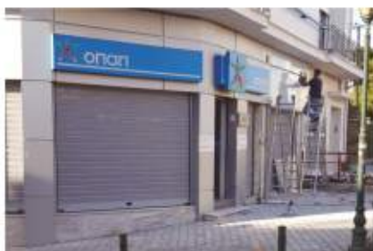
τοποθέτηση επένδυσης ETAL BOND στα πρότυπα της Ενιαίας Εταιρικής Εικόνας
