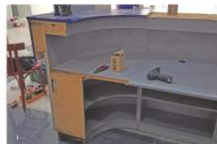
μεταφορά - τοποθέτηση πάγκων συναρτησίων & συμπληρώματα στα πρότυπα της Ενιαίας Εταιρικής Εικόνας
