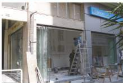
τοποθέτηση τζαμαριών TRIPLEX πτυσσόμενα φύλλα πόρτες SECURIT
