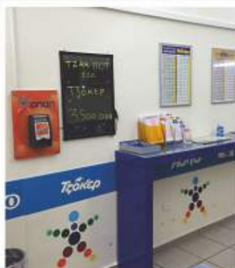
No.03 προστασία τοίχου με πλέξιγκλας μέχρι το δάπεδο
