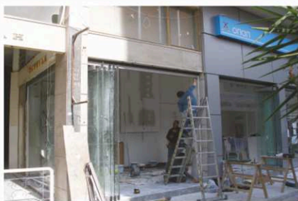
τοποθέτηση τζαμαριών TRIPLEX πτυσσόμενα φύλλα πόρτες SECURIT
