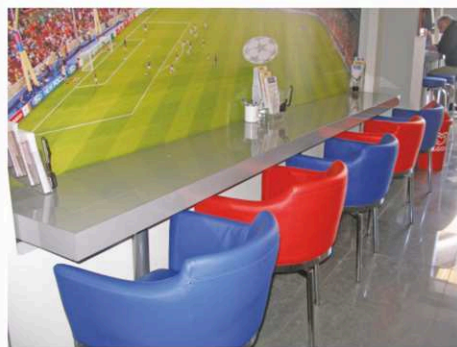
επιτείχια κατασκευή από χοντρό HPL
